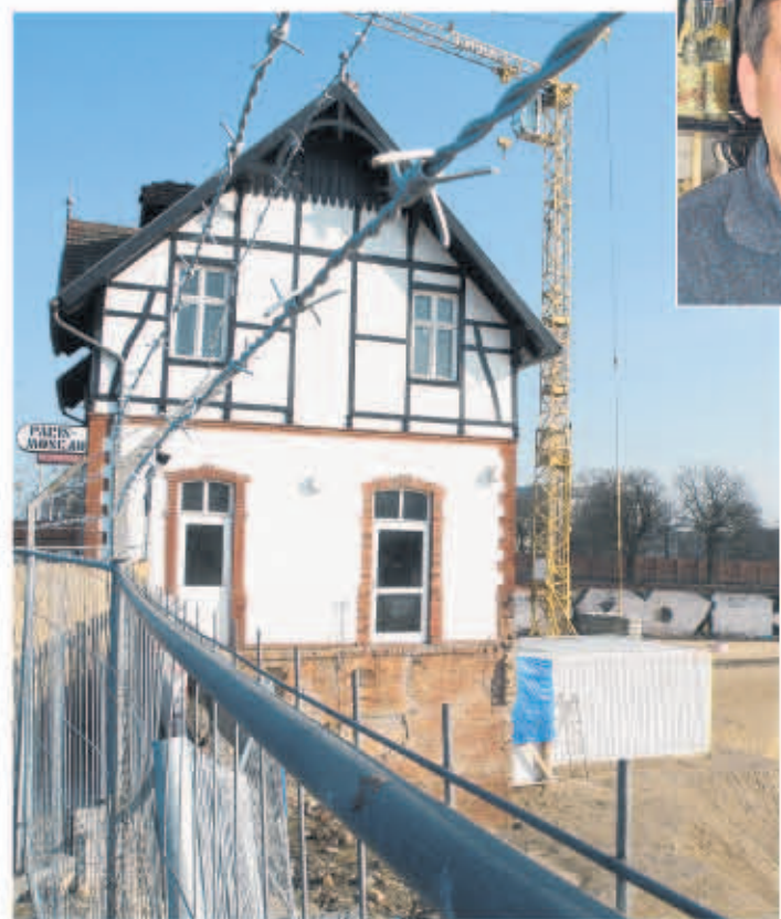
Hinter dem Paris-Moskau ist die Baugrube schon ausgehoben. Nur beim Restaurant kann man noch auf die Baustelle gucken. Fotos: Völlering
