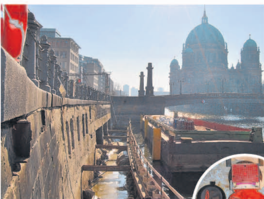
Am Fuß der Friedrichsbrücke sind drei Auslässe zu sehen, durch die bei starkem Regen Abwasser in die Spree fließt – zurzeit ist der Auslass trockengelegt, weil die Kanalisation erneuert und das Spreeufer wieder so hergestellt wird wie 1912.
